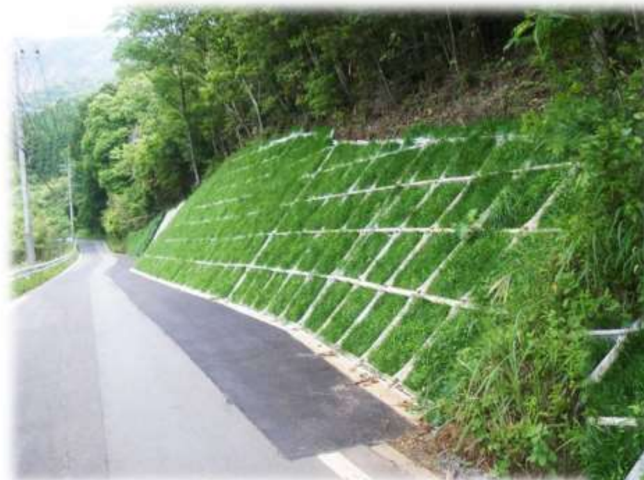
Sau thi công 2 tháng
